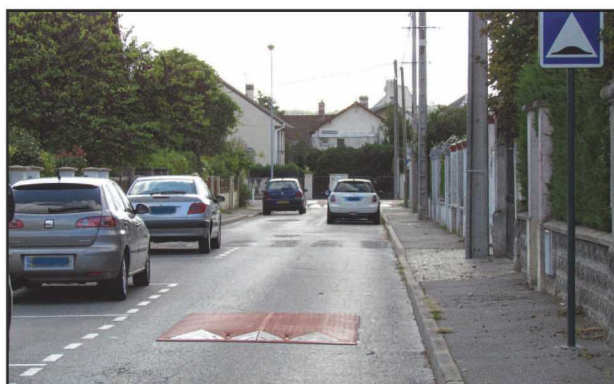
rue Aristide Briand - pose de ralentisseurs
