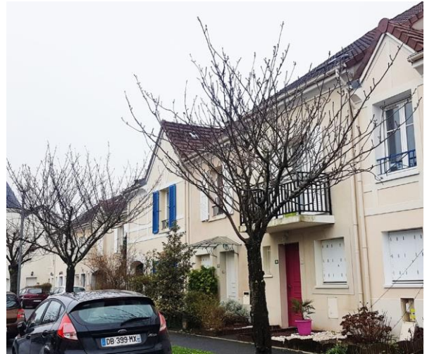
Opération groupée pavillonnaire (photo : CAUE 95)
