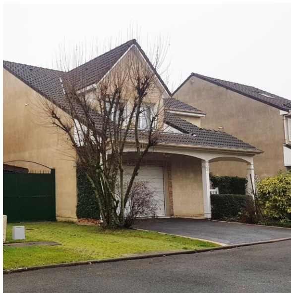
Opération groupée en lotissement (photo : CAUE 95)
